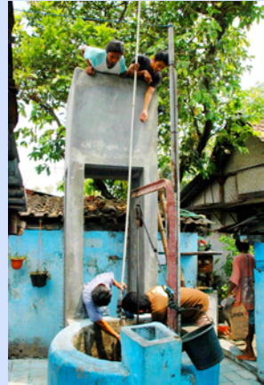
Penyediaan air bersih
